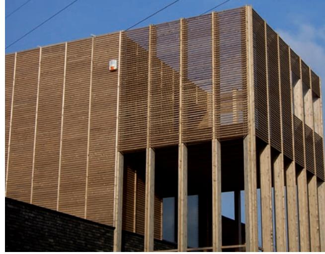
Om vervorming te vermijden werden de 8,5 meter hoge staanders uitgevoerd in gelijmd gelamelleerde Plato®Hout.
